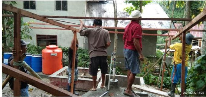
**Gambar 9. Pembuatan rumah instalasi reactor biogas dan pengolahan pupuk organik cair**
