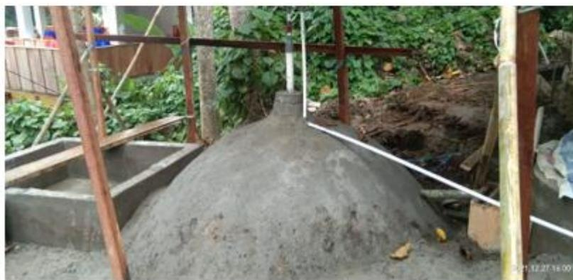
*Gambar 7. Pembuatan kubah*
