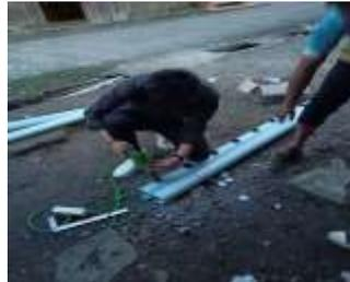
Gambar 2. Proses pembolongan pipa menggunakan holesaw
