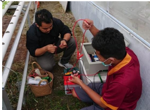
Gambar 8. Proses instalasi Perangkat PLTS pada UMKM terkait
