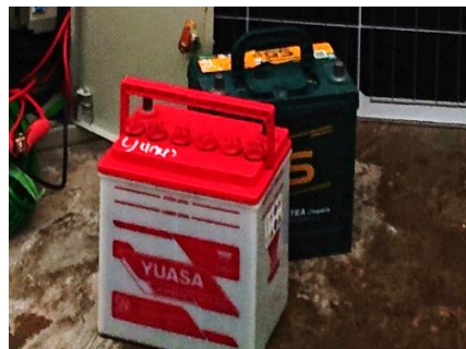
Gambar 3. Aki 12 Volt dengan kapasitas 35 Ah.
