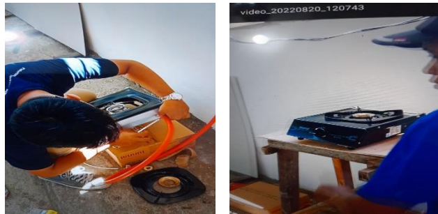
Gambar 6. Pemasangan dan penyambungan slang kompor gas
