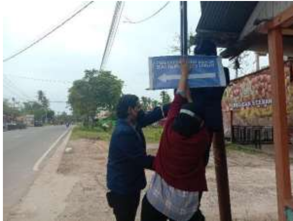
Gambar Lampiran 2 Pemasangan Plang Arah Pantai (Sumber : Penulis, 2022)
