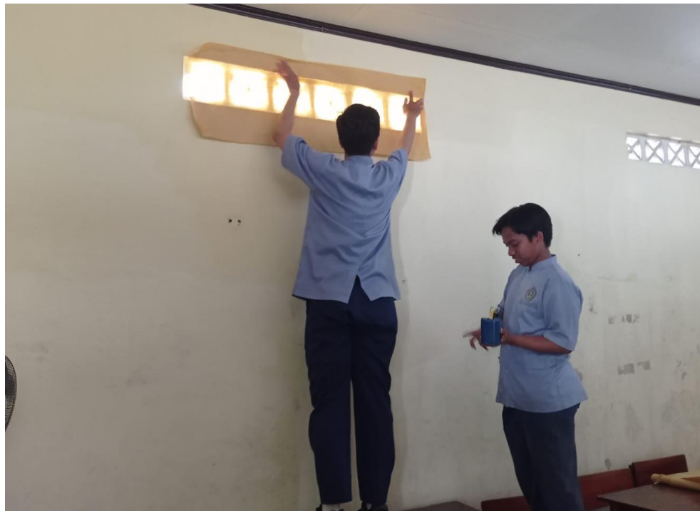
Gambar 3. Kegiatan Pelaksanaan Penutupan pada ventilasi
