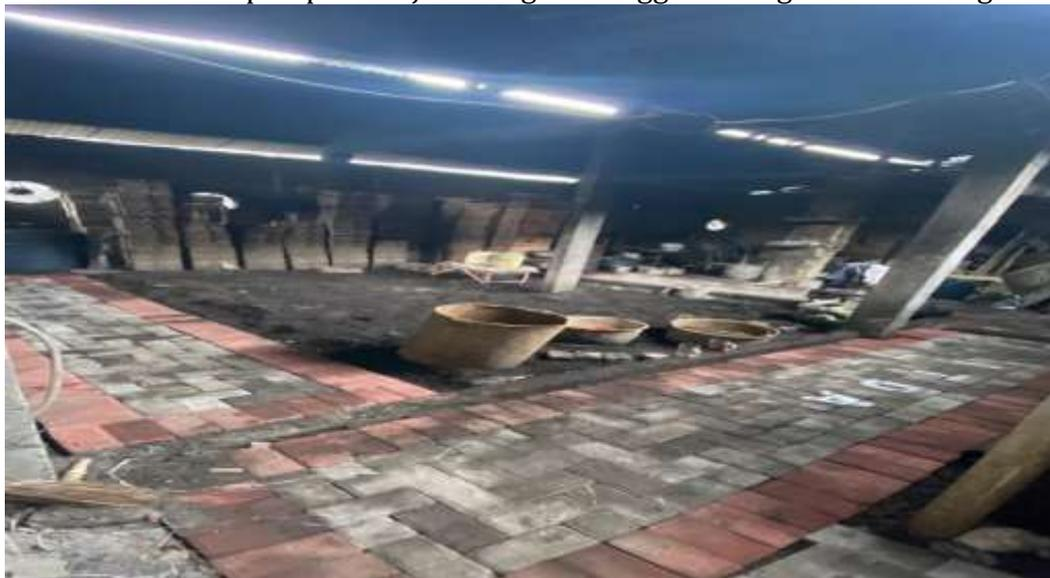
**Gambar 5. Pemasangan *Paving Block* untuk Area Pencetakan**
