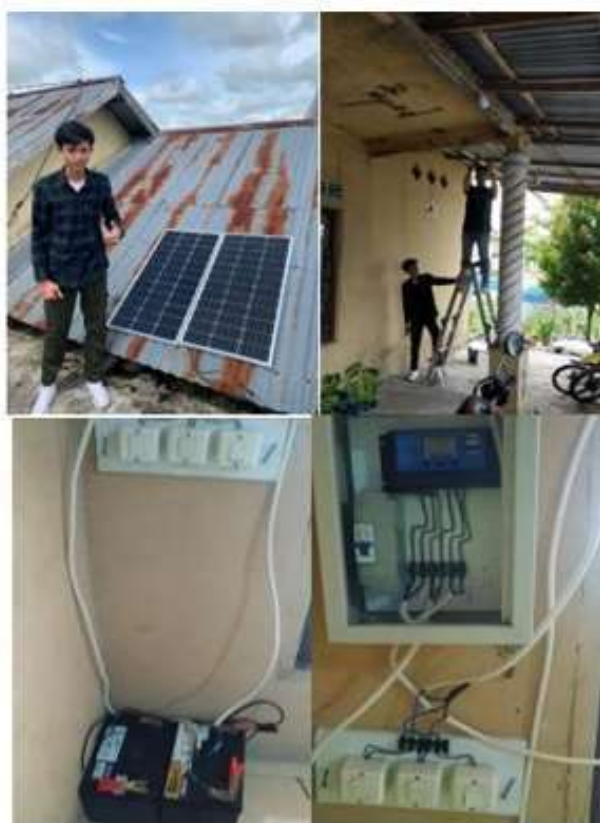
Gambar 2. Pemasangan Instalasi PLTS
