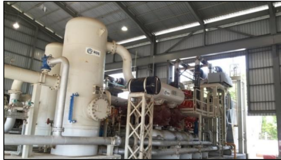
Gambar 2. Kompresor Gas di SKG X (Depan)
