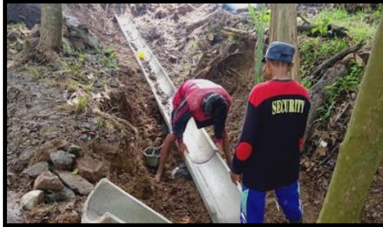
Gambar 6. Kegiatan Perbaikan Sirkulasi Air di Sempadan Waduk Jatibarang
