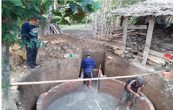
**Gambar 1. Pembuatan Reaktor Biogas**
