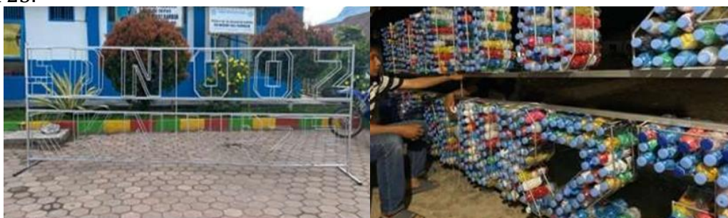
Gambar 6. Penyusunan Ecobrick ke Dalam Kerangka Ecobrick
