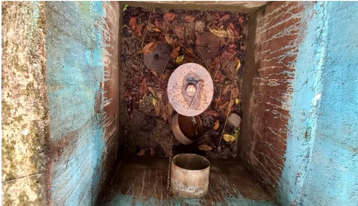
Gambar 3. Bak Transisi Distribusi Air Sawah di Gampong Luthu Aceh Besar
