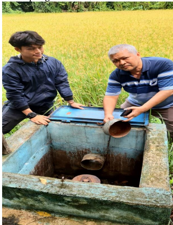
Gambar 4. Penutup Pipa 4 Inchi untuk Mengatur Laju Alir Air Distribusi ke Sawah
