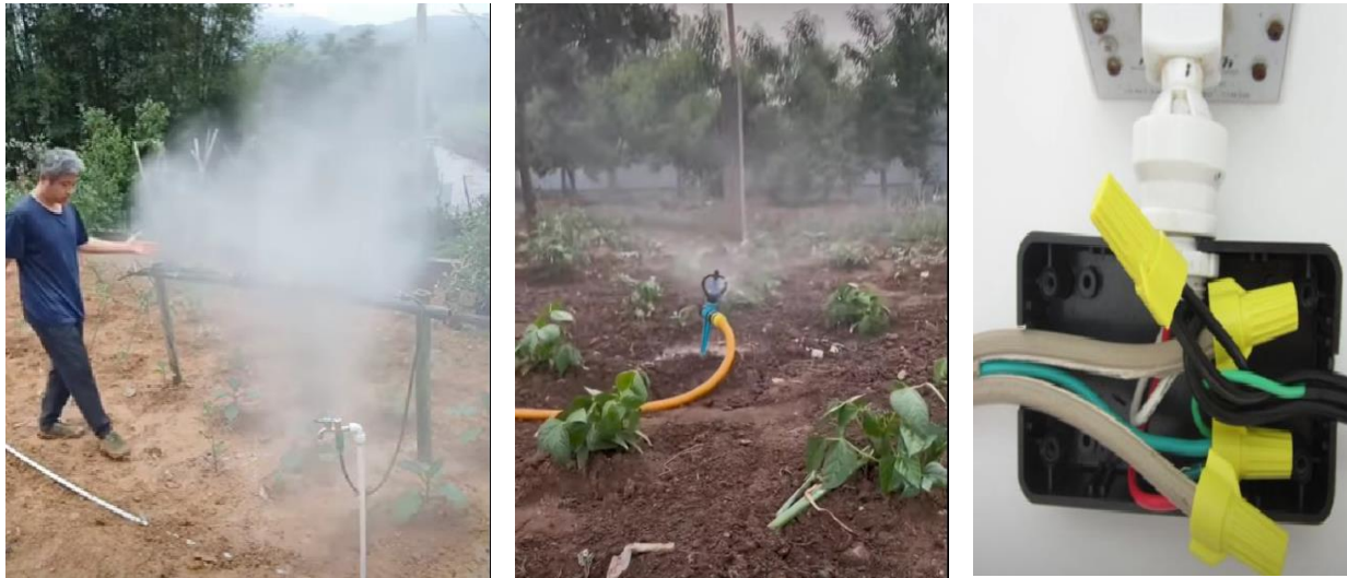
Gambar 3. Pemasangan Instalasi semprotan air untuk taman
